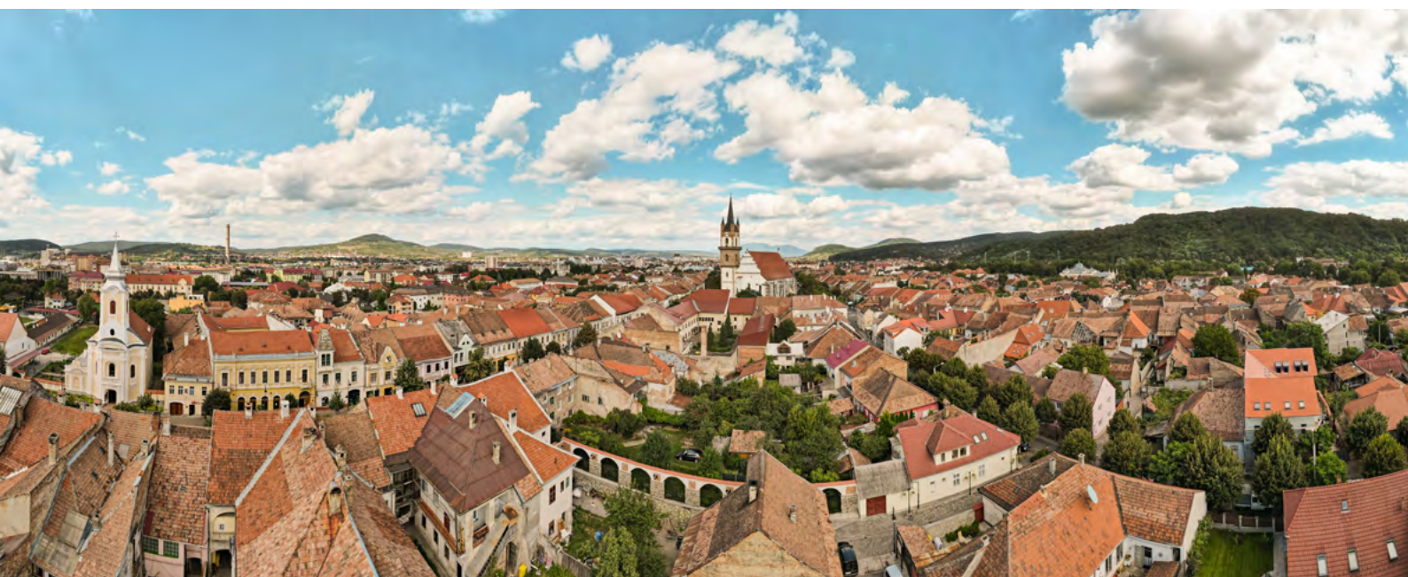
Centrul istoric al Bistriței - ritmul acoperișurilor cu țiglă ceramică oferă originalitate și autenticitate vechiului burg
