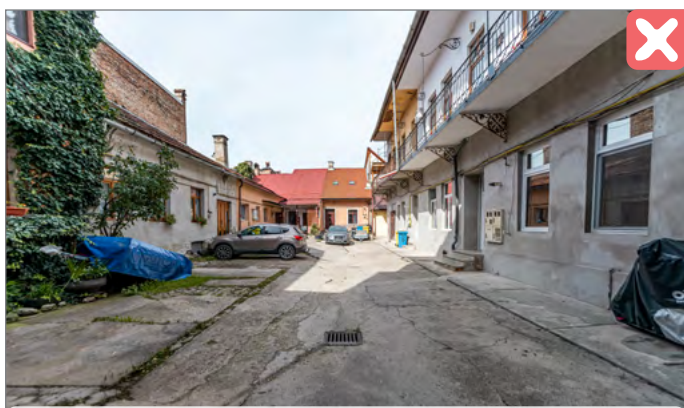
Curte întreținută și amenajată incorect cu suprafețe betonate ce întrețin umiditatea în zidăria istorică
