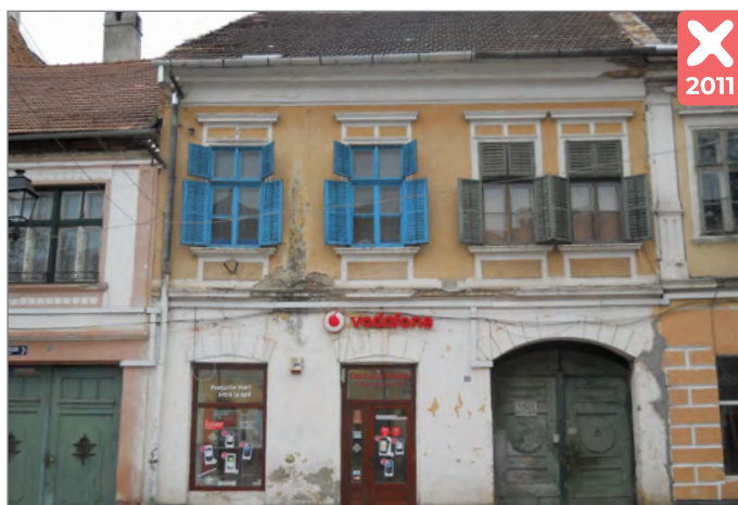
Fațada înainte de reabilitare
