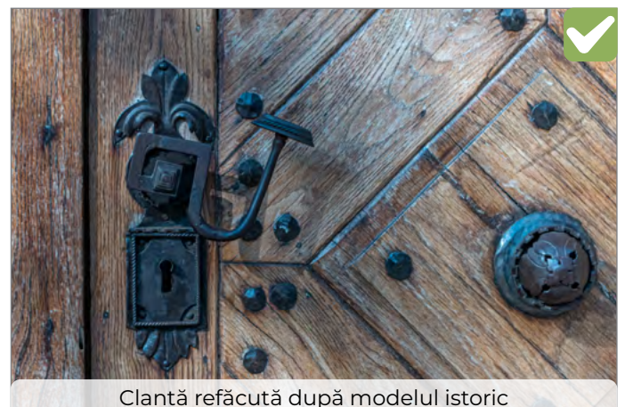
Mâner corect refăcut pentru șildul istoric
