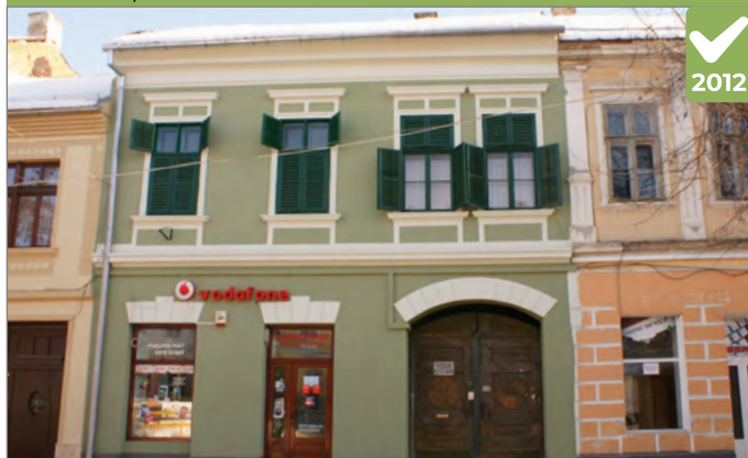
Fațada după reabilitarea imobilului, dar fără intervenție la parter
