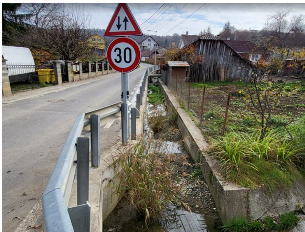
Imagine 5.20 Rigola str. Cocorului amonte str. Valea Budacului
