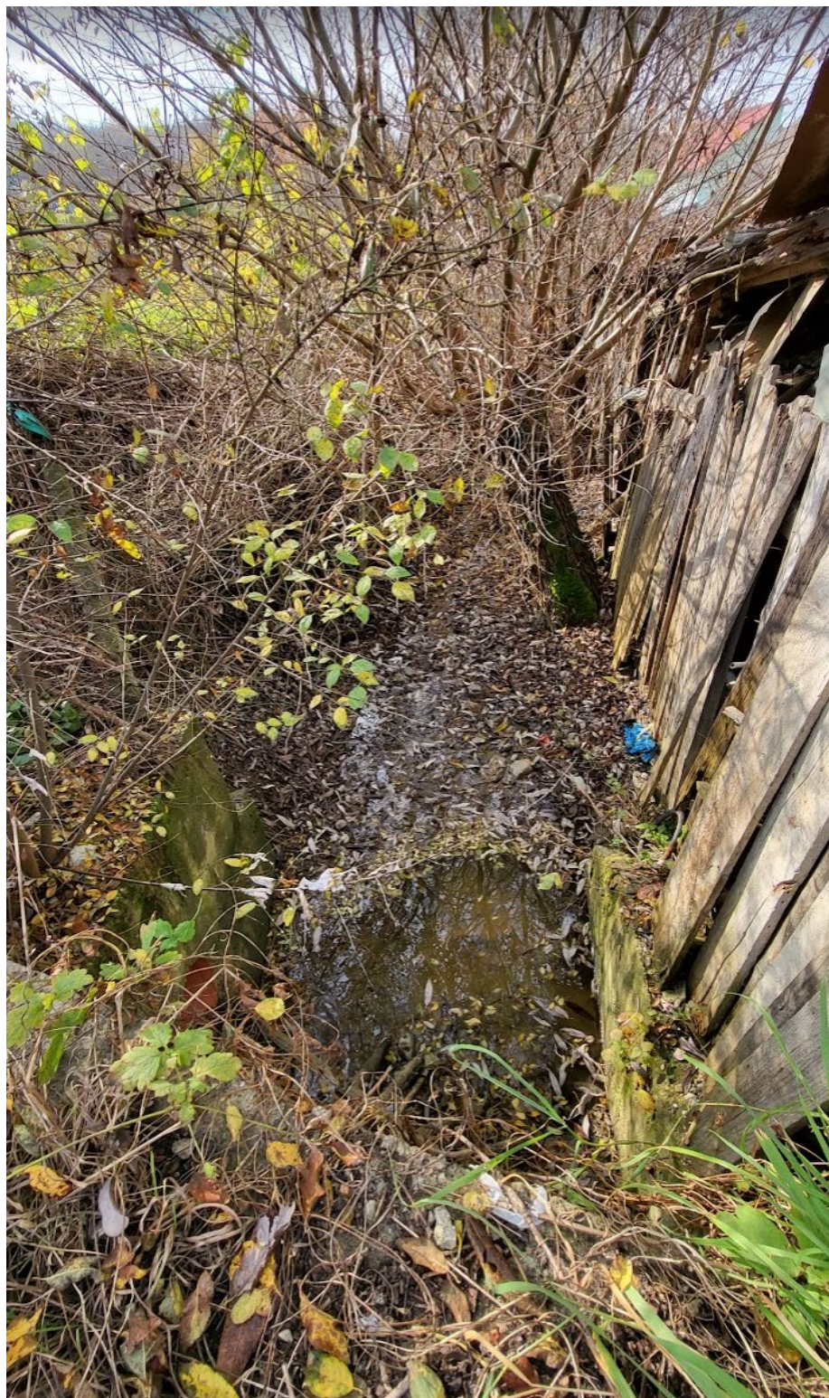
Imagine 5.15 Rigola str. Umbroasă aval str. Valea Budacului
