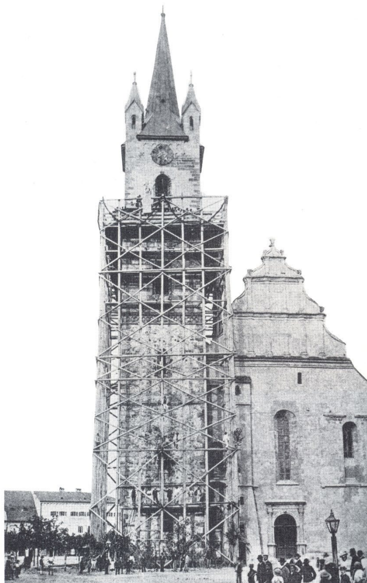
Restaurationsarbeiten am Turm der ev. Kirche 1903
