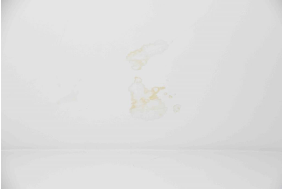
Foto nr. 47 – Degradări cauzate de infiltrații de apă de la nivelul acoperișului – sală activități parter
