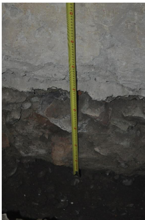
Foto nr. 63 – Măsurători sondaj fundație S1
