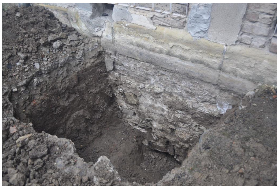
Foto nr. 64 – Sondaj fundație S2
