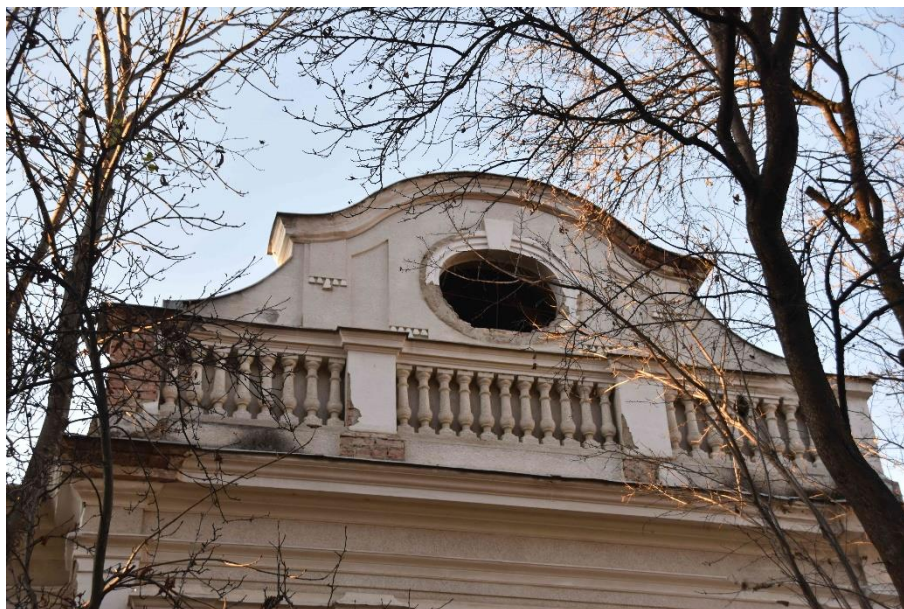
Foto nr. 7 – Aspect timpan - fațadă sud-estică
