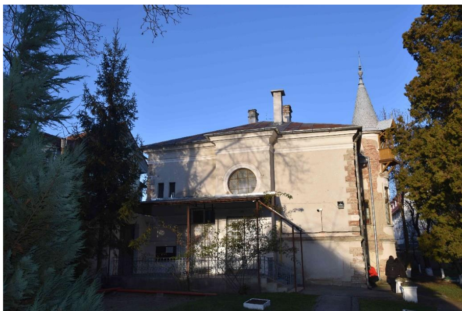
Foto nr. 10 – Fațadă sud-vestică
