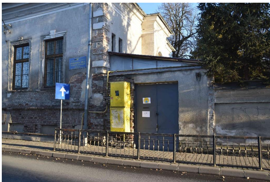
Foto nr. 2 – Aspect poartă de acces – fațadă nord-vestică
