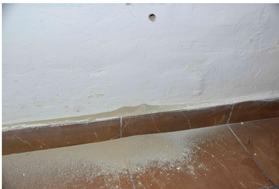
Foto nr. 66 – Găuri sondaj perete demisol
