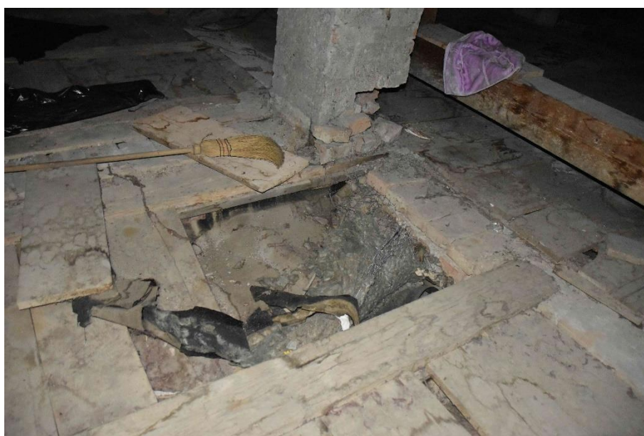
Foto nr. 68 – Sondaj planșeu de pod
