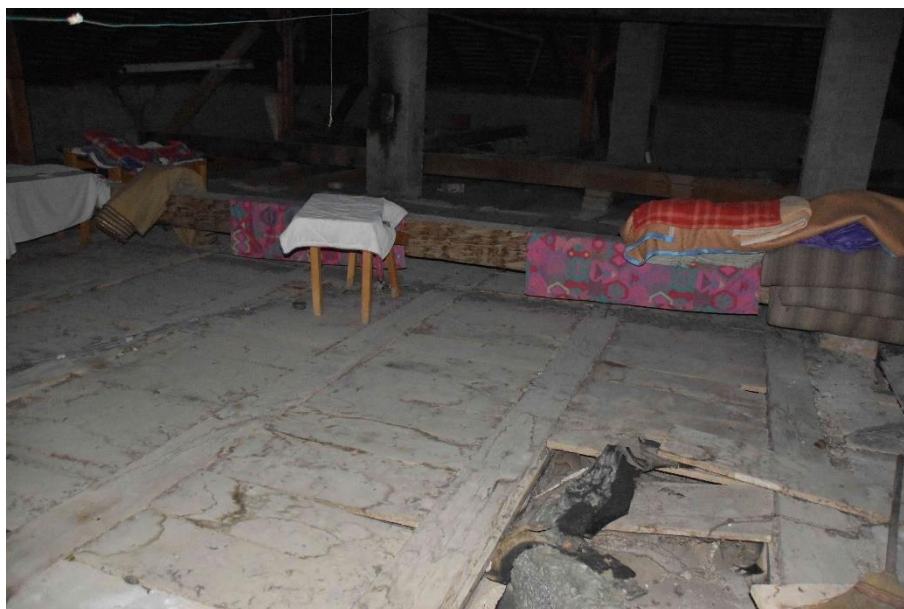
Foto nr. 50 – Aspect general planșeu de pod
