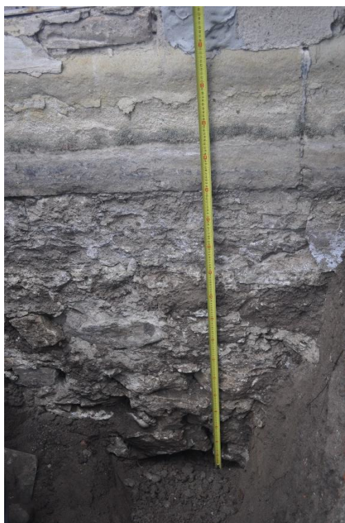
Foto nr. 65 – Măsurători sondaj fundație S2
