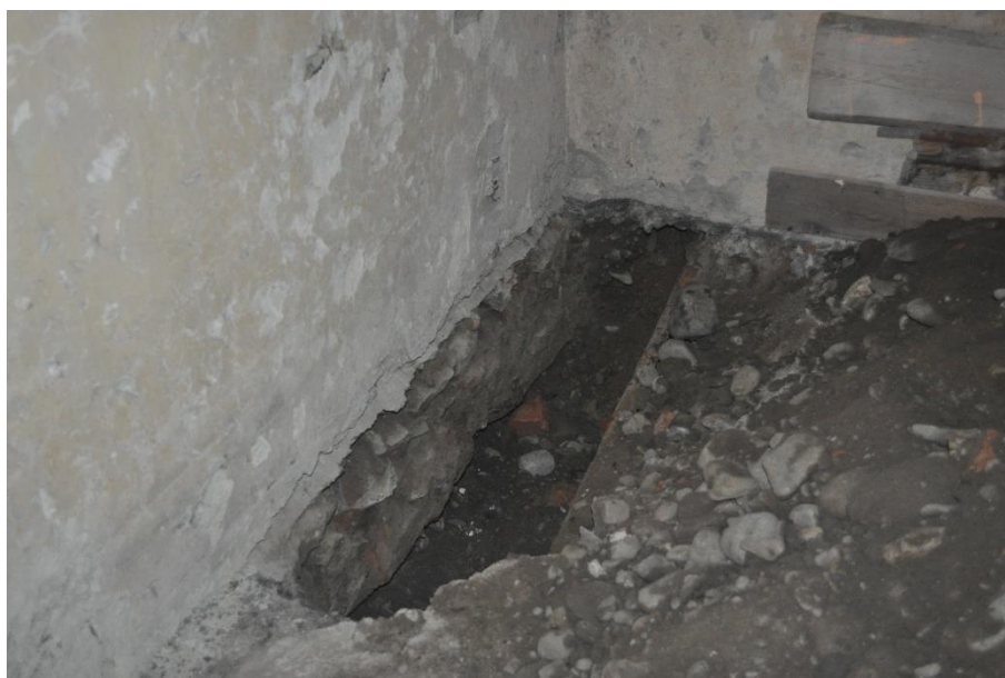
Foto nr. 62 – Sondaj fundație S1
