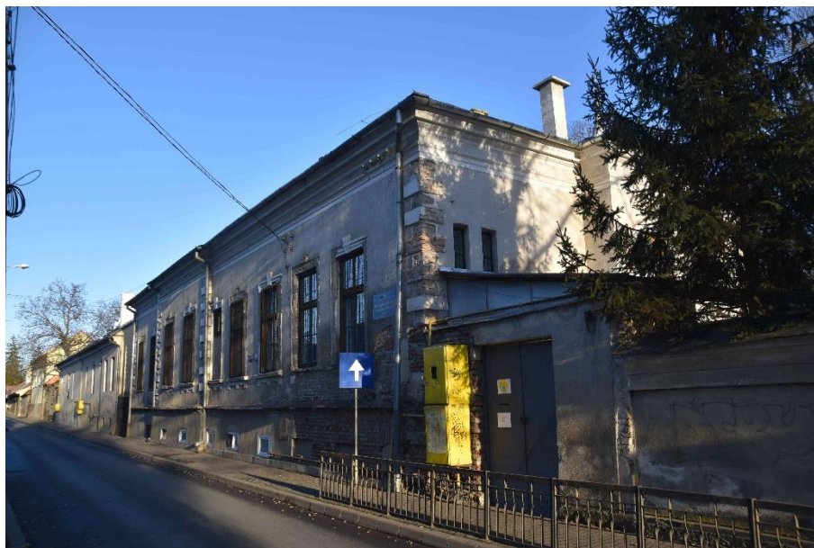
Foto nr. 1 – Fațadă nord-vestică
